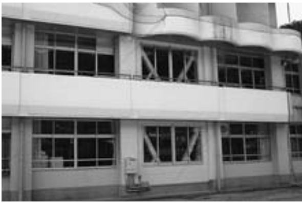
神山東中学校耐震工事
