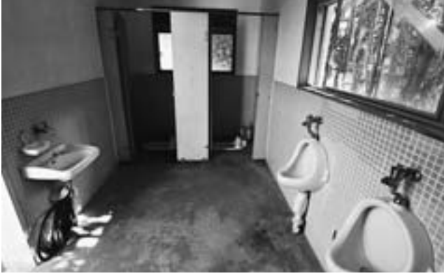
下分小体育館トイレの内部
