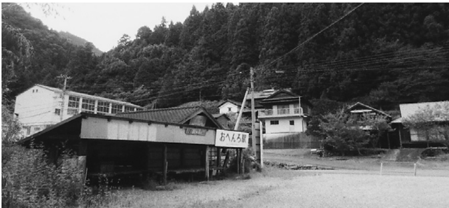
災害危険区域である左右内鍋岩地区
