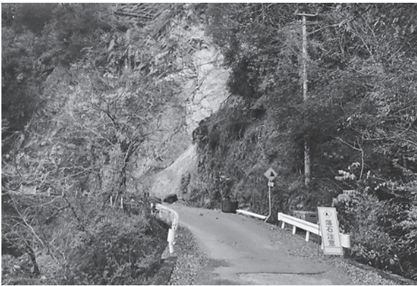
国道438号 (上分字府殿) 災害現場
