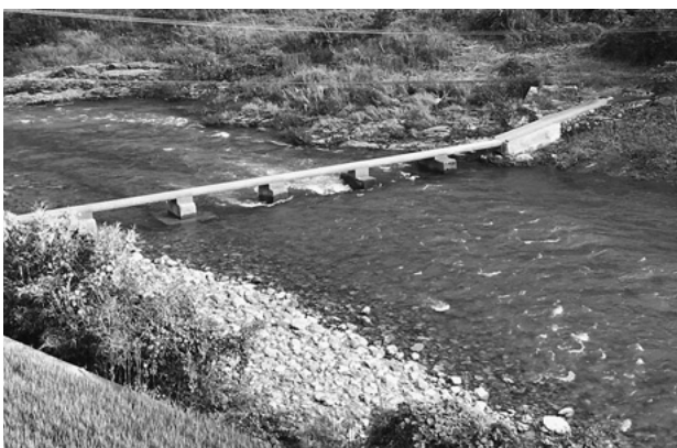
駒坂橋の現況
