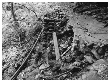
崩れている歩道
