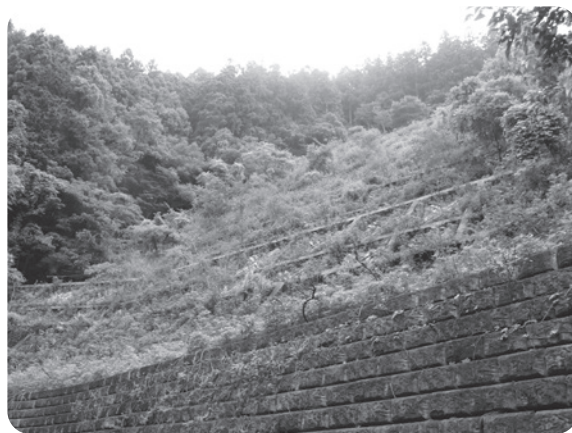
植林さんの自宅近く、平成21年に実施された地すべり対策工事。
