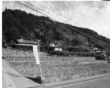
復旧後の農地
