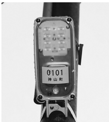
▲新たに設置したLED防犯灯器具
