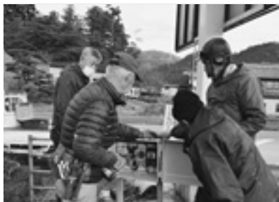
▲中川電気さんを中心に配電盤を設置
