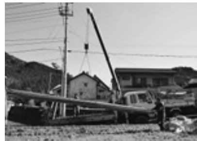
▲クレーン車を使い鉄塔を設置
