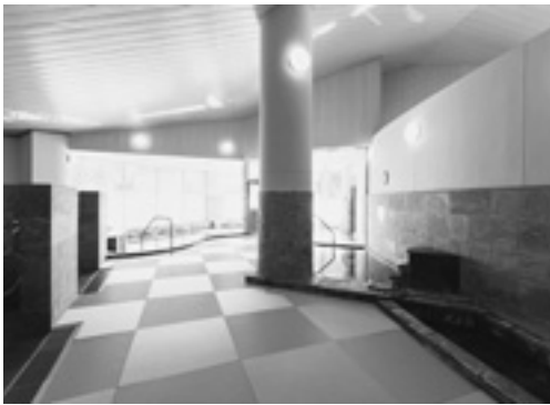
▲畳敷きにリニューアルされた浴室
